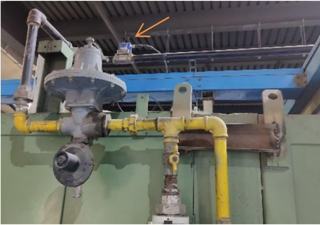
Pour une unité de fabrication de bouteilles en verre, Eletta a fourni une solution complète de 8 unités de débitmètres de la série M en raccords filetés de 1", modèle M310-G25SS, pour les 8 différentes lignes de brûleurs de gaz GPL mesurant une plage de débit de 6,5 à 65 Nm<sup>3</sup>/h.
