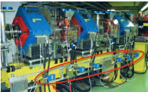
CERN, Frankreich. Hochvoltmagnete fokussieren den Partikelstrahl. Eletta Strömungswächter überwachen den Kühlkreislauf.
